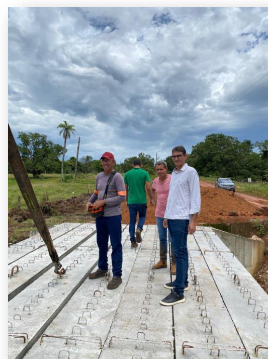
Obra da Ponte do Jenipapo avança e será entregue em breve
